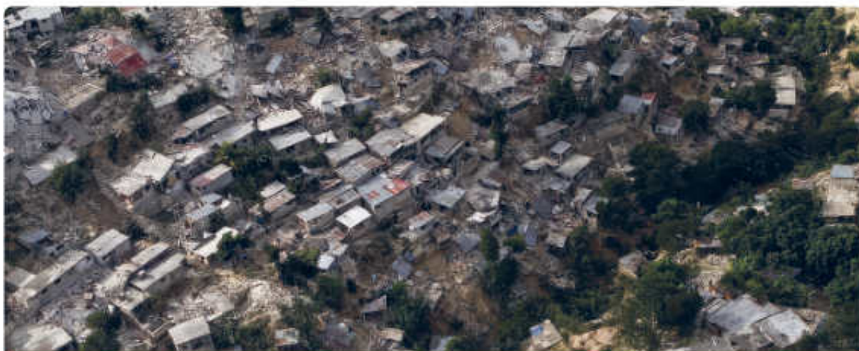
Bairro com danos após terremoto em Porto Príncipe, no Haiti, em janeiro de 2010.
